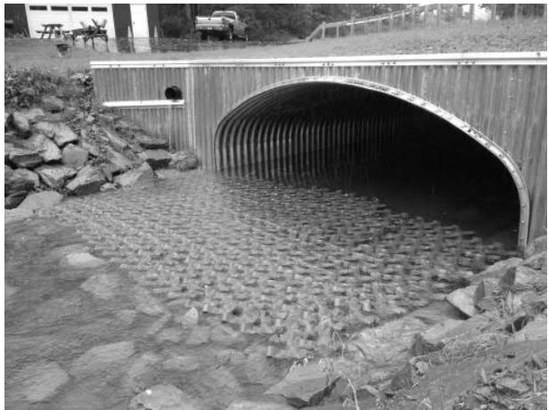
A-JACKS PARTIAL INVERT N.T.S.
