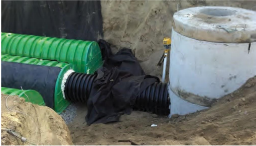
S-22 MANHOLE HEADER ROW
